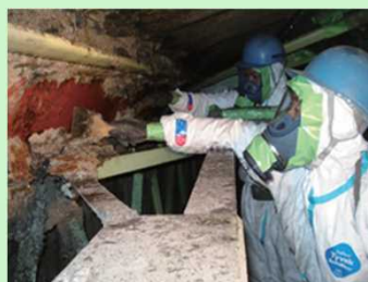
吹付け石綿の除去作業の様子
