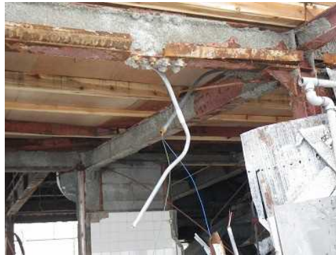
建物に残存した吹付け材
