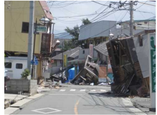
地震で損壊した建物
